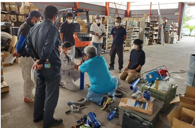
皆さん知っていましたか？上水道は鉄管のイメージがあると思いますが、現在は配水用ポリエチレン管というポリエチレン樹脂の製品を使う事が増えています！何が良いかって、災害時の柔軟性！鉄管は硬くて丈夫ですが、津波や液状化など、管に側面から圧力がかかった場合、ある一定以上の圧力になると繋ぎ目が割れてしまいます。しかし、ポリエチレン管は融着という技術で接合しているので、管同士が一体となり、その柔軟性で追従することによって断裂を防ぎます。「葦は嵐に耐えられるが、桺の木は倒れる」という英語圏のこわざの通りでしょうか。(日本だと「柳に雪折れなし」かな？)メーカーの商品と現場の正確な技術により、街のインフラは守られているんですね！あ、もちろん当社も必須ですよ！！
